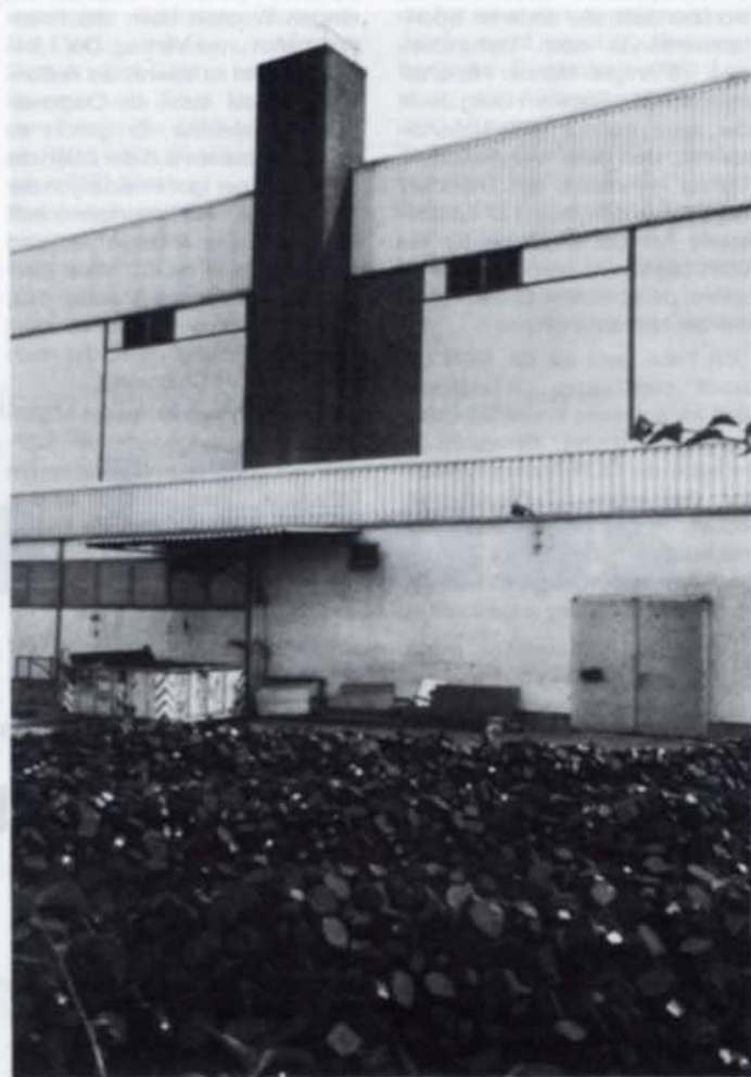
Hinter der 1984 gebauten Trainingshalle der Volleyballer des SC Schwerin türmen sich die Brikettberge, Brennmaterial für die Kohleheizung. Foto: Krohn
